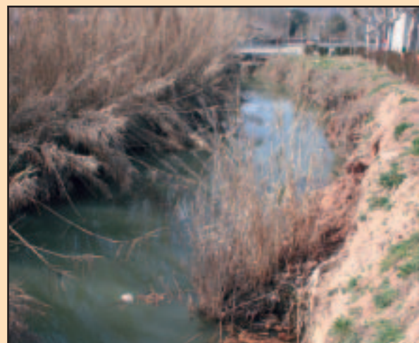
El projecte de canalització permetrà continuar urbanitzant la zona del canal
