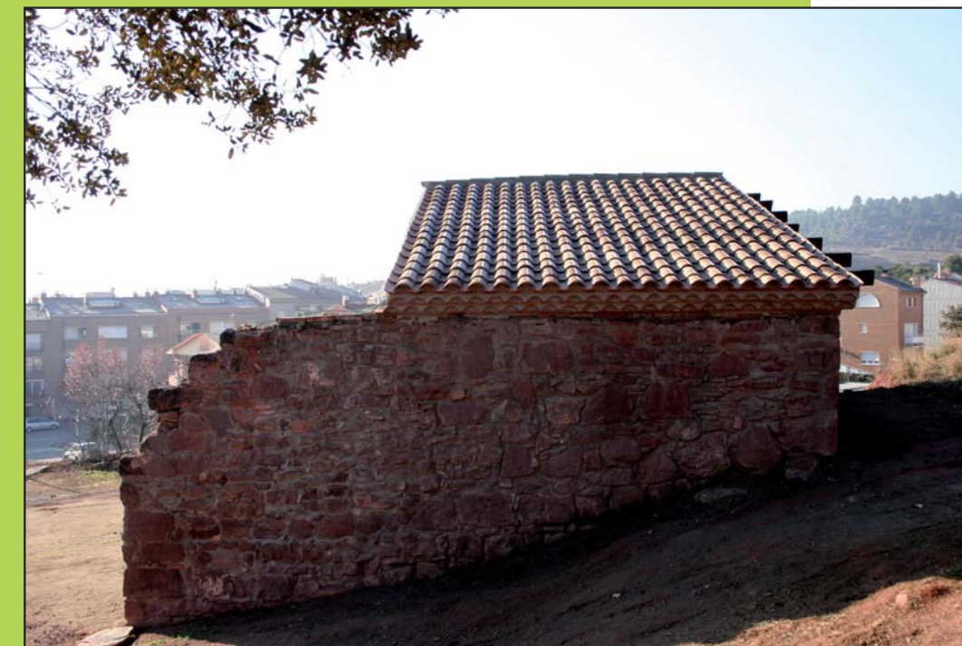
Rehabilitació teulada cobert era Mas Llobet
