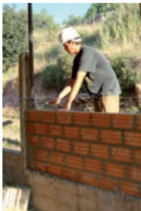
Mòdul de construcció
