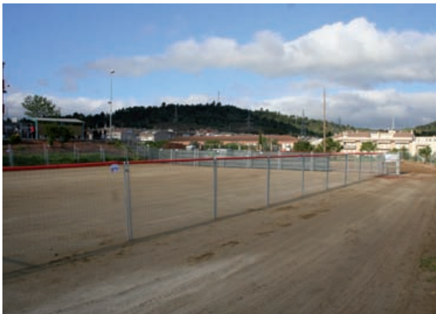
Obres nou CEIP Joncadella. Vista parcial del pati habilitat i del carril de servei per als vehicles de l'obra
