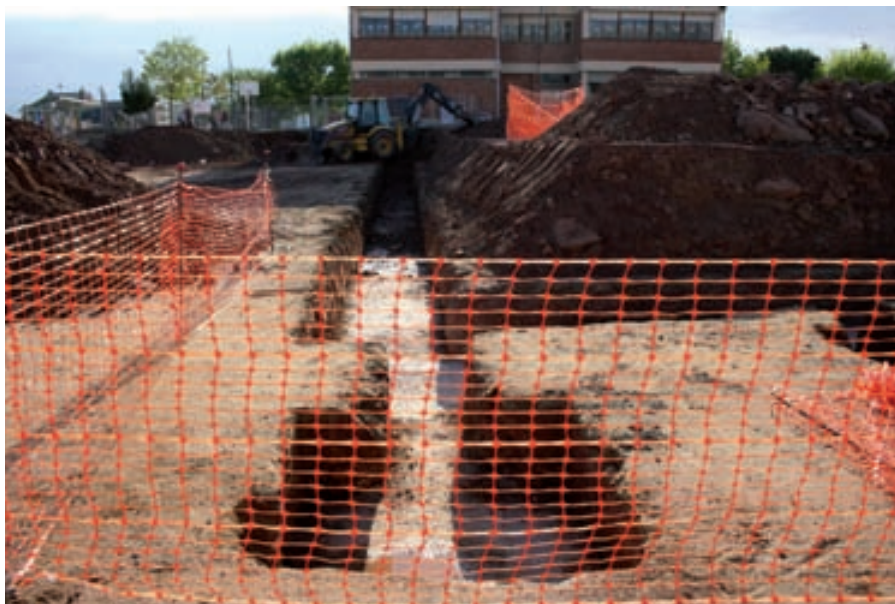
Obres nou CEIP Joncaella. Moviment de terres i fonamentació
