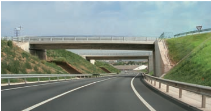
Nou accés al Centre Penitenciari Lledoners
