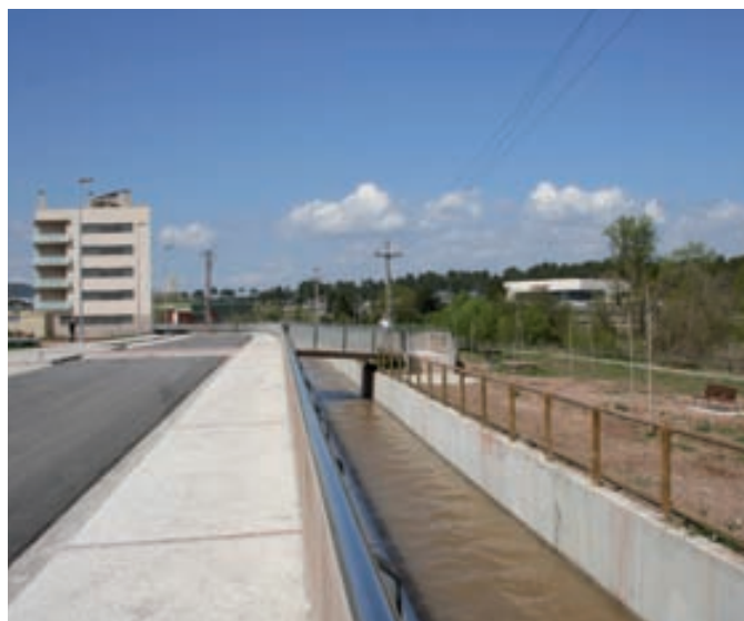
Urbanització Pla Parcial del Canal
