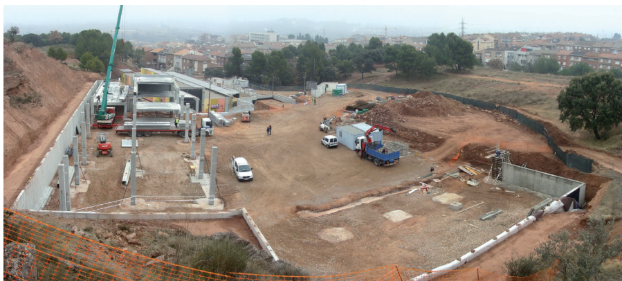
Obres de l'edifici de Primària a l'escola Ametllers.
