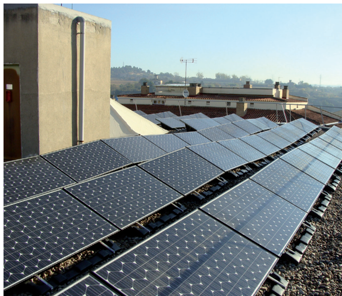
Projecte de millores d'eficiència energètica a l'edifici de l'Ajuntament: col·locació de plaques fotovoltaiques.
